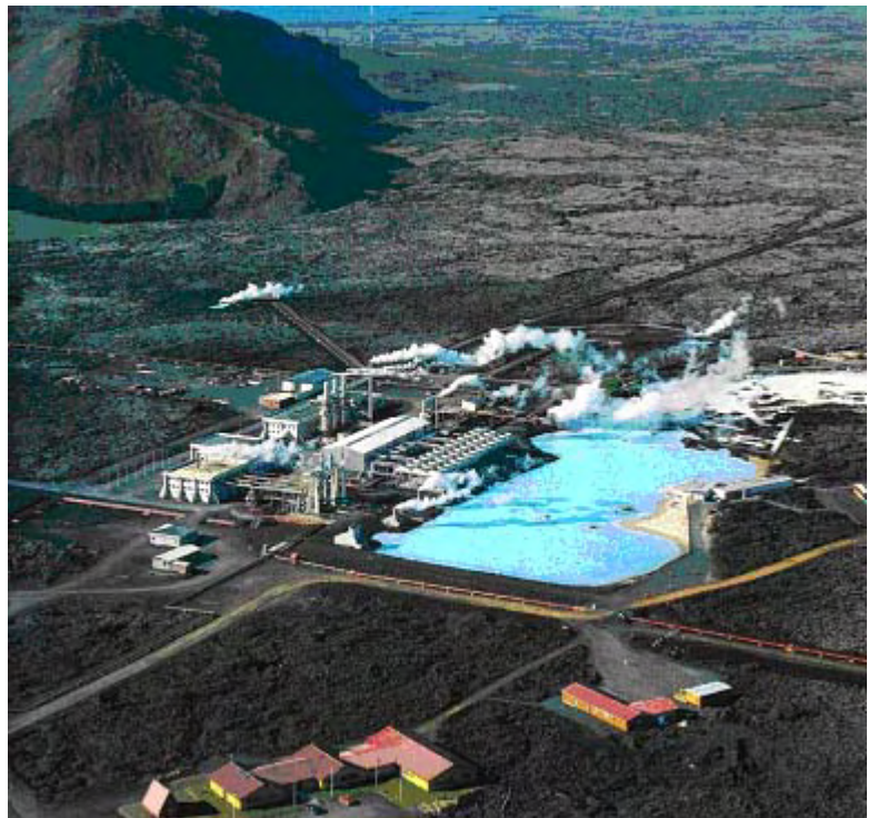
写真15 Svartsengi 発電所全景
